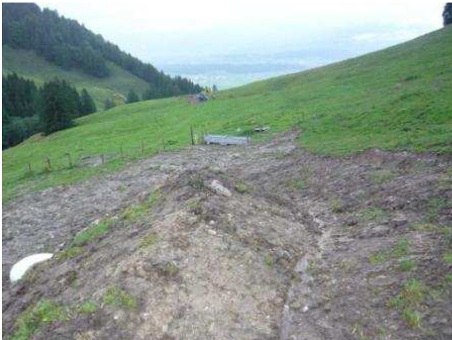
Der eingerichtete Schutzwall, um die Sicherheit vor Wassereinbrüchen zu erhöhen.
