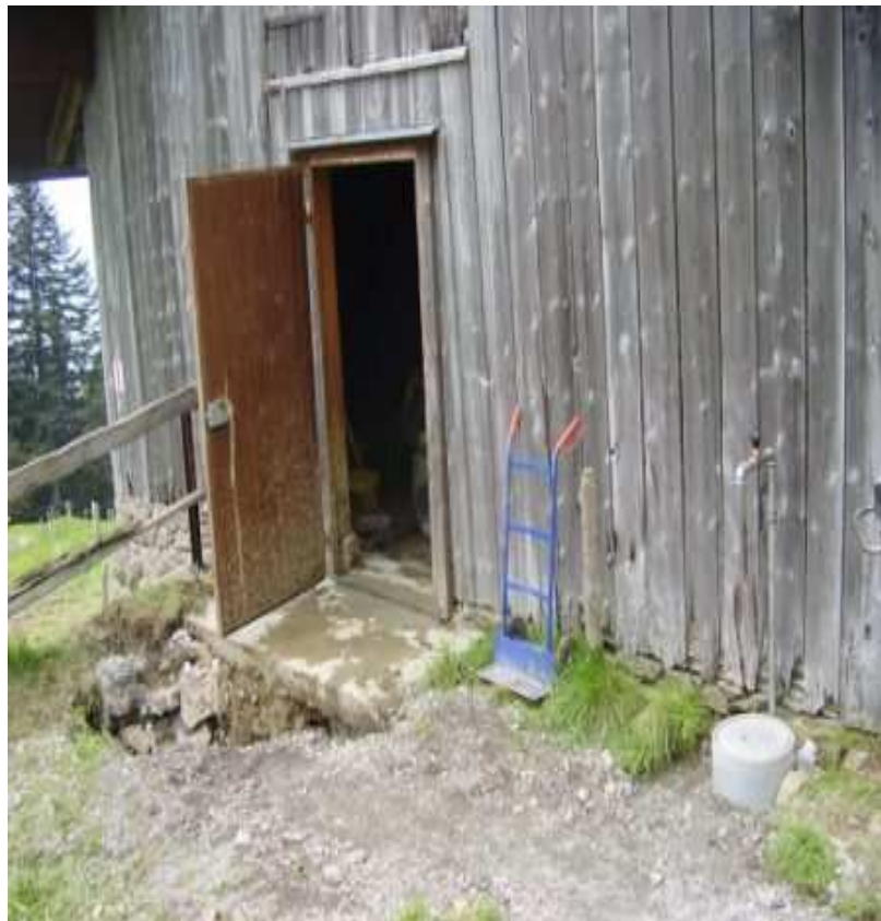
- neu erstellter Wasseranschluss des Alpstalls Zwyrenggli -
