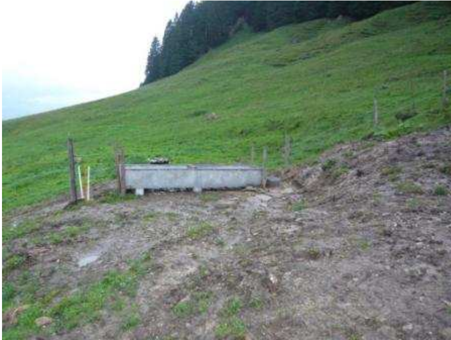
- neu erstellter Brunnentrog unterhalb vom Reservoir -
