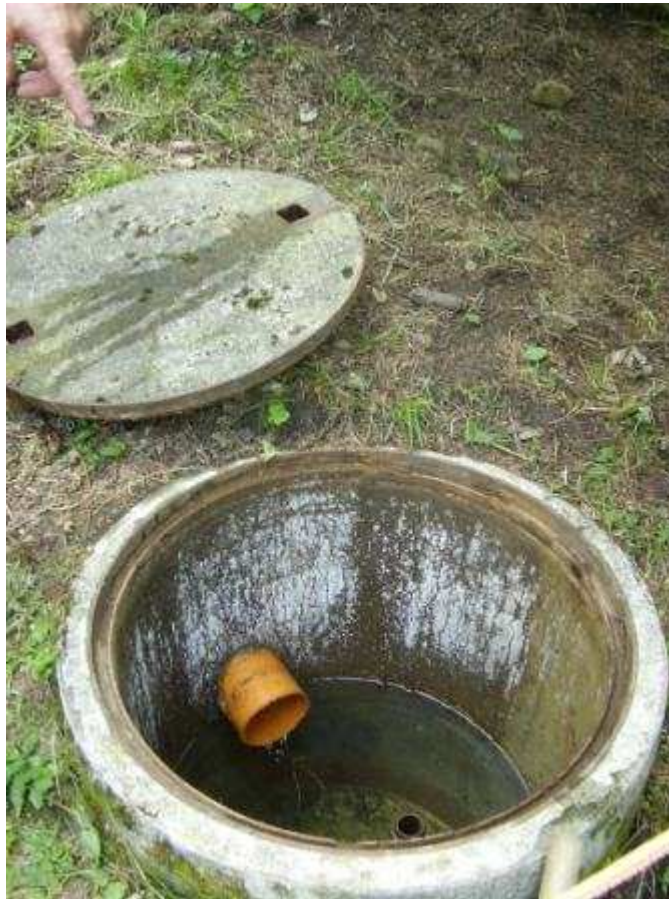
Die Fassung der Platten-Quelle, wie sie bis vor der Sanierung war. Von hier fließt das Wasser ins Reservoir.
