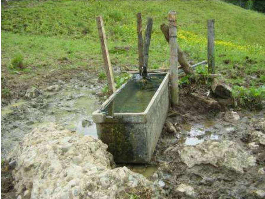
Zustand bei der Wasserstelle Bigligen vor der Sanierung...
