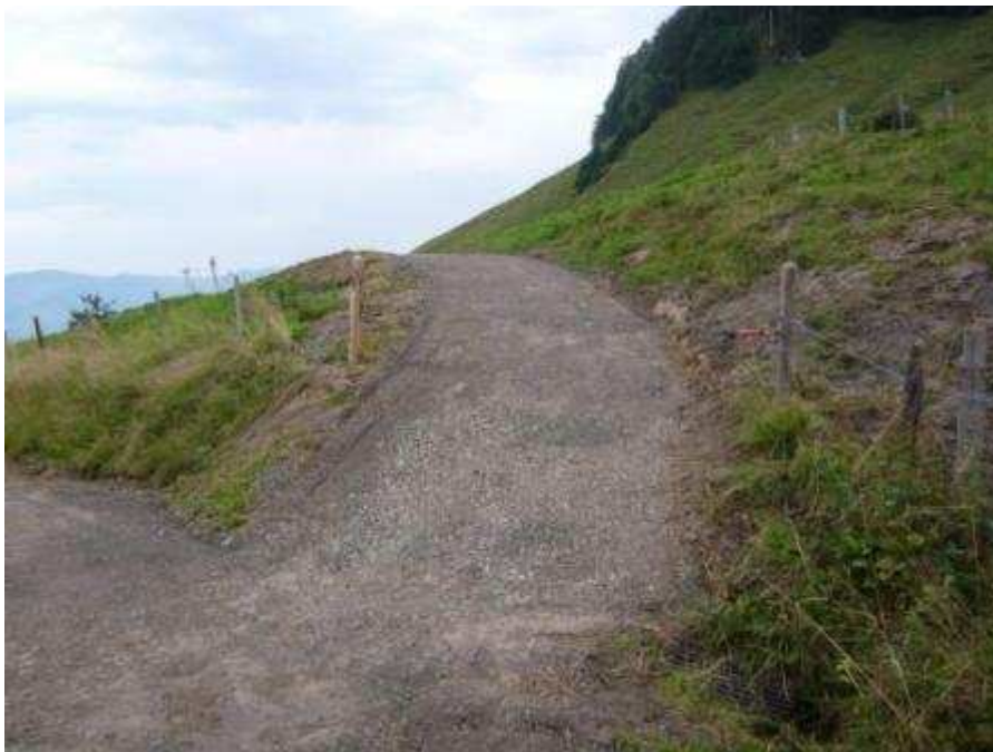
- Einfahrt zum neuen Bewirtschaftungsweg -
