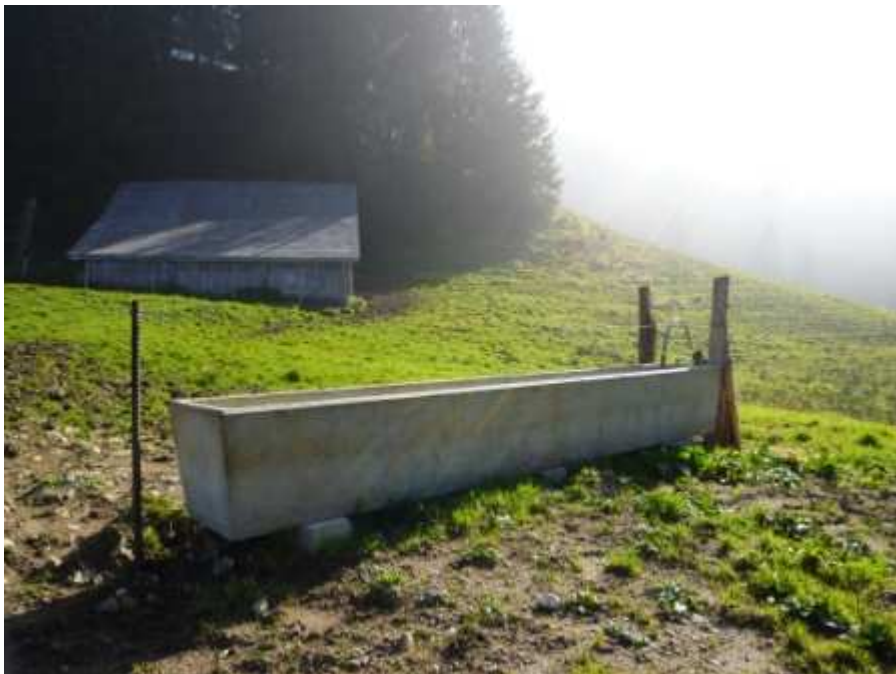
...und nach der Sanierung mit dem neuen Brunnentrog mit Schwimmerventil.
