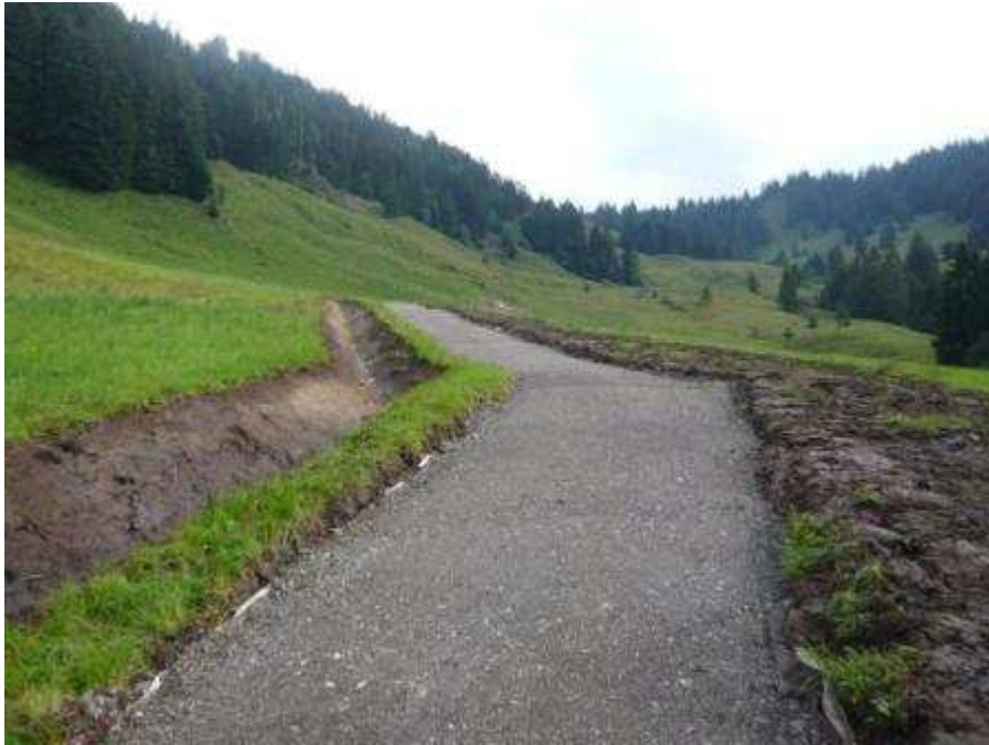
- fertig erstellter Bewirtschaftungsweg -
