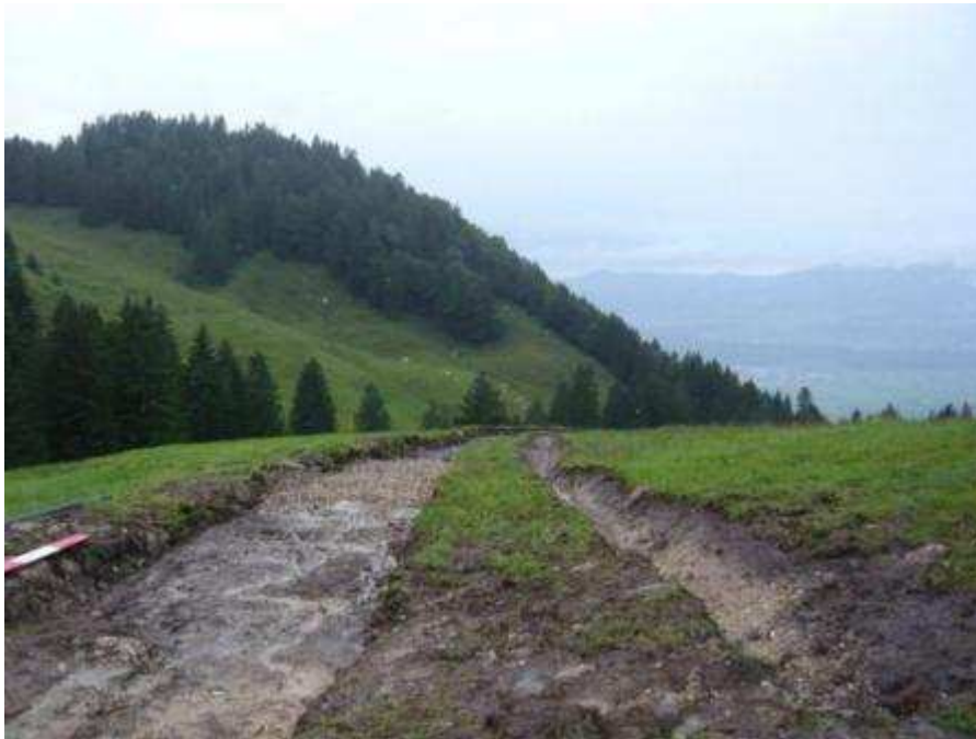
- Bauarbeiten am Bewirtschaftungsweg –
