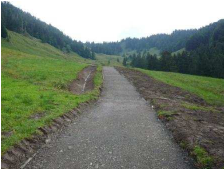
- Entwässerungsrinne mit Strassenunterquerung und Abfluss -
